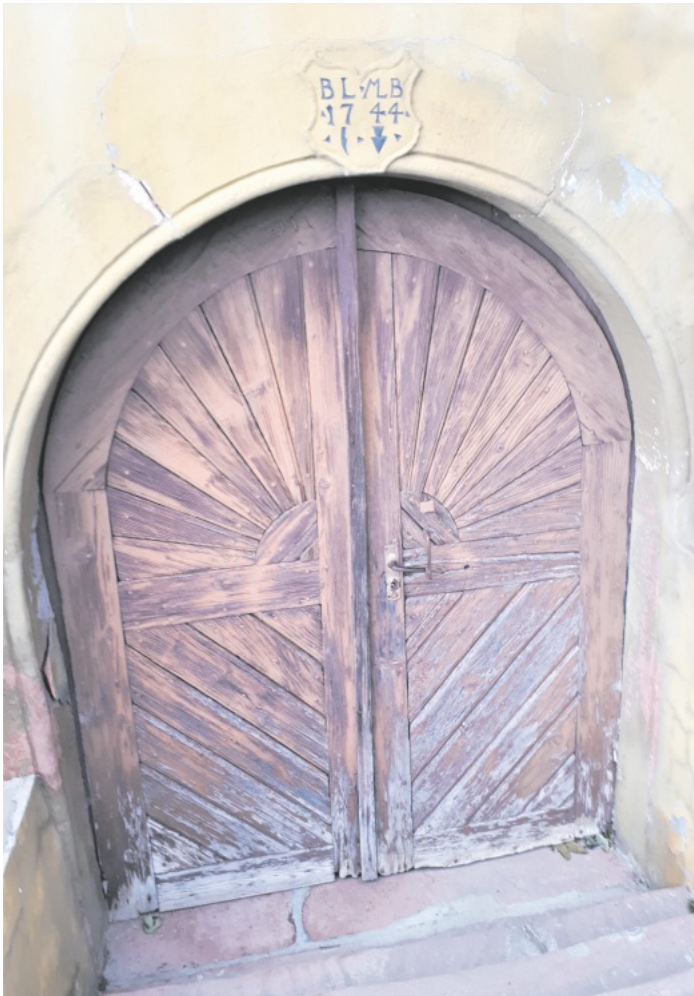
Kellereingang Pfundstein, ehemals Balthasar Lienhard, 1744
